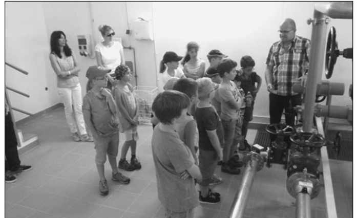
Im Rohrkeller erläuterte Bautechniker Roland Bangert den Kindern die Funktionsweise des Hochbehälters „Talberg“.
