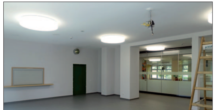
Die neue Mensa kurz vor ihrer Fertigstellung.
