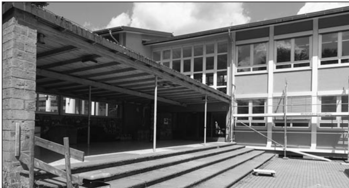
Die Pausenhalle bekommt ein neues Dach, eine Rampe und einen Windfang.
