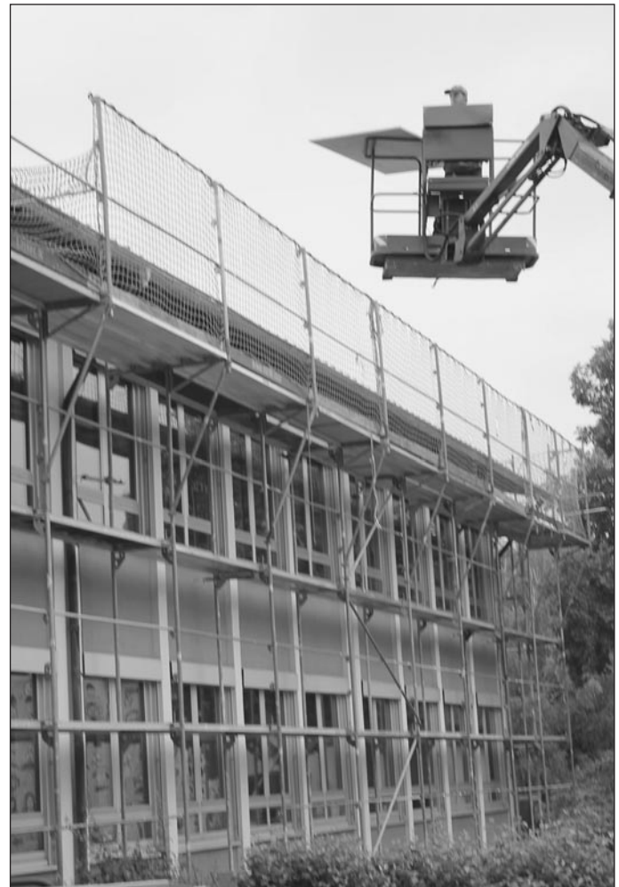
„Arbeiten in luftiger Höhe – die Dachdeckerarbeiten sollen bis zum Ende der Sommerferien abgeschlossen sein.“
