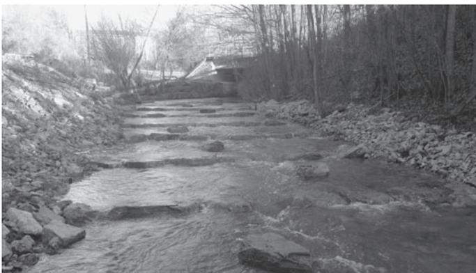
*Stromabwärts des Durchlasses in Zimmern ist der alte Absturz der Seckach bereits zurück gebaut und anstelle dessen eine für Fische durchwanderbare Sohlengleite geschaffen worden. Die Länge dieser Sohlengleite beträgt etwa 40 m. Beim Vergleich des alten Zustands mit der neu gebauten Sohlengleite lässt sich deutlich erkennen, dass aus dem ehemals für Fische unüberwindbaren Hindernis ein naturnaher Abschnitt mit unterschiedlichen Fließstrukturen geworden ist.*
